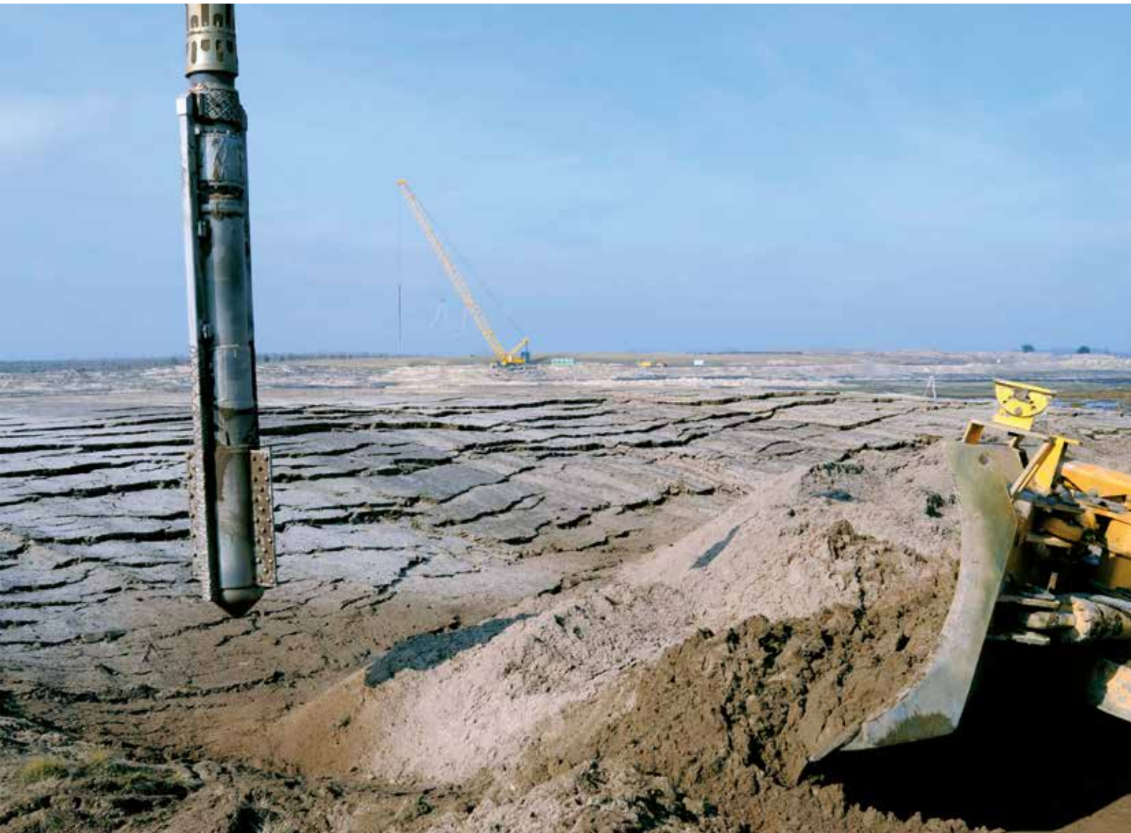
Rütteldruckverdichtung im Innenkippenbereich des ehemaligen Tagebaus Schlabendorf, 2008 (o.) Begutachtung einer Aufforstung junger Roteichen durch LMBV-Förster auf der Innenkippe Zwenkau (u.l.) Gelungene Rekultivierung im ehemaligen Tagebau Meuro, 2007 (u.m.) Rotwild in der Bergbaufolgelandschaft Seese-West (u.r.)
