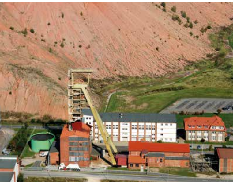
Bergwerksanlage Bischofferode, 2007 (o.l.) Beraubegerät bei der First-Prüfung einer Strecke im Bergwerk Sollstedt, 2007 (o.r.) Füllen von Bohrlöchern für eine Sprengung im Bergwerk Sollstedt, 2003 (u.l.) Bergwerksanlage Bleicherode, 2007 (m.r.) Lader bei der Gewinnung von Salz zum Versatz im Bergwerk Sollstedt, 2007 (u.r.)
