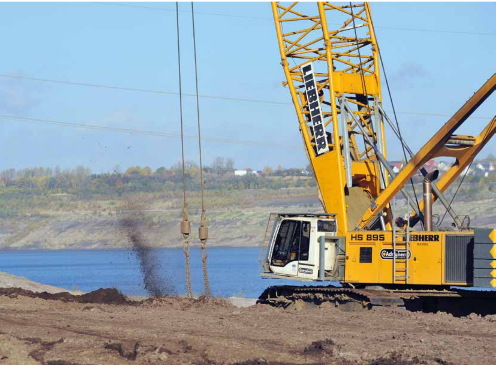
Fallplattenverdichtung am Lappwaldsee im ehemaligen Tagebau Wulfersdorf, 2013 (o.) Hafen Tauchritz am Berzdorfer See, 2012 (u.l.) Barbarakanal (Überleiter 9) zwischen Partwitzer See und Geierswalder See, 2012 (u.r.)
