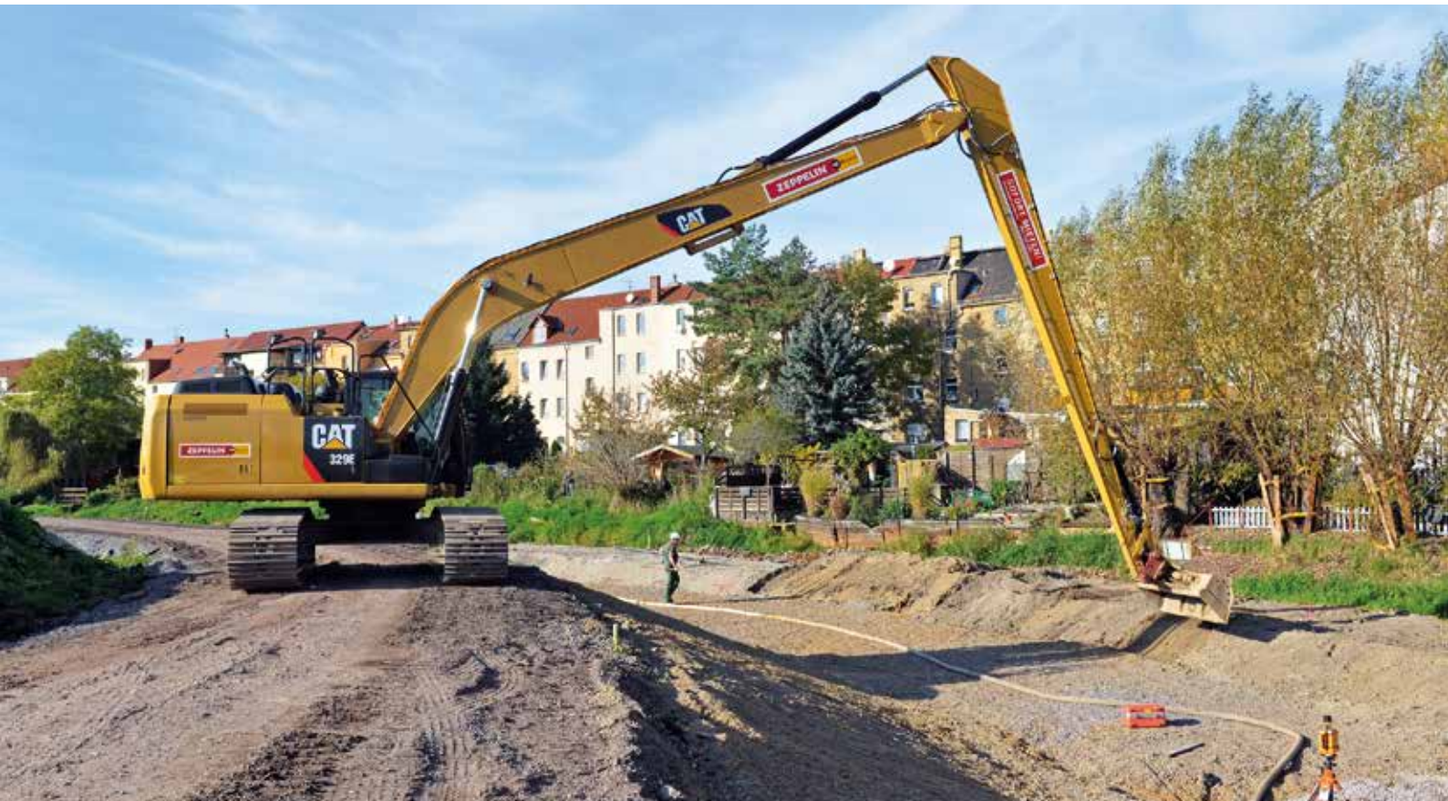
Bagger mit langer Grabenausrüstung bei der Böschungprofilierung zum Loberausbau in der Innenstadt von Delitzsch (o.) Bau eines Horizontalfilterbrunnens zur Grundwasserabsenkung, Laugfeld in Senftenberg (u.l.) Rüttelstopfverdichtung am Ufer des Silbersees, 2012 (u.r.)
